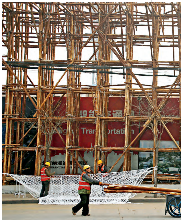
2016年12月31日，工人在北京一建筑工地施工。
